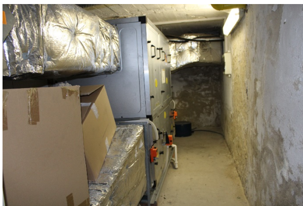
Obrázek 33 - VZT jednotka pro větrání kuchyně v hlavní budově ZŠ
