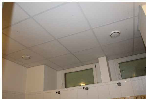
Obrázek 57 - Podtlakové větrání - Sociálky v hale
