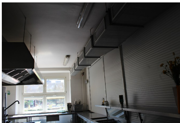
Obrázek 34 - VZT potrubí a distribuční elementy pro větrání kuchyně
