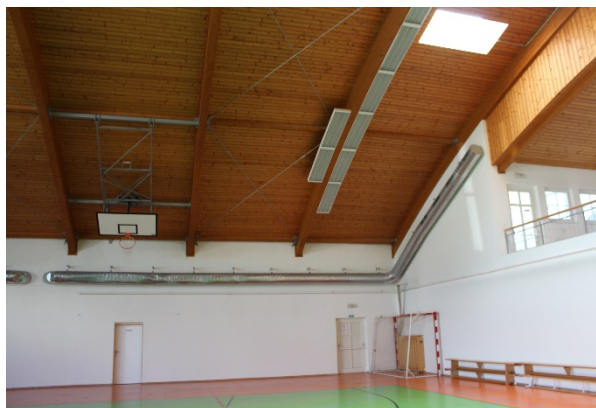
Obrázek 37 - VZT potrubí a distribuce
